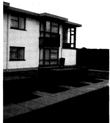
図6 コリンシール：2階建て住棟
