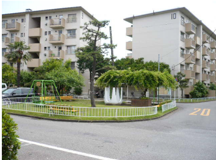
写真5 稲毛海岸3丁目団地の外観
