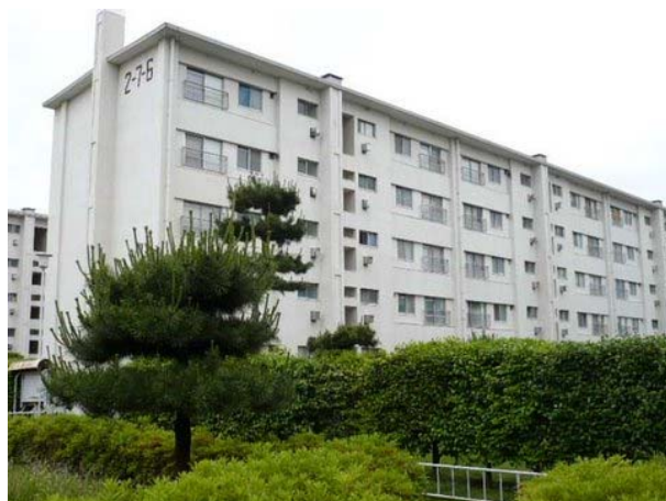
写真 3 袖ヶ浦住宅の建物の外観
