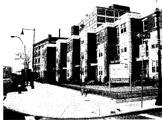
写真4 イースト・ボストン 建て替え後の公営住宅 Maverick Landing
